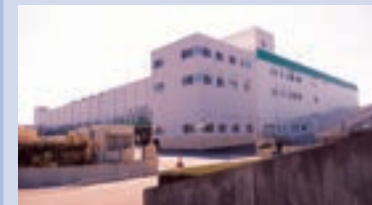
中部支店（平成24年3月増築棟稼働）
