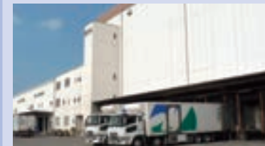
東京支店第二センター（平成24年6月稼働）
